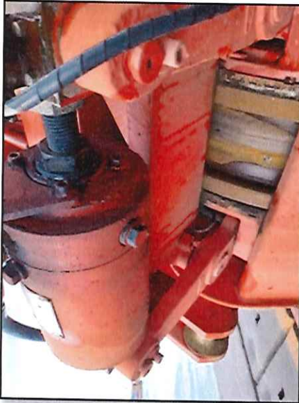
Local: Gantry Item # 02: pequeno vazamento de óleo em um dos cilindros de freio das rodas do Gantry.
