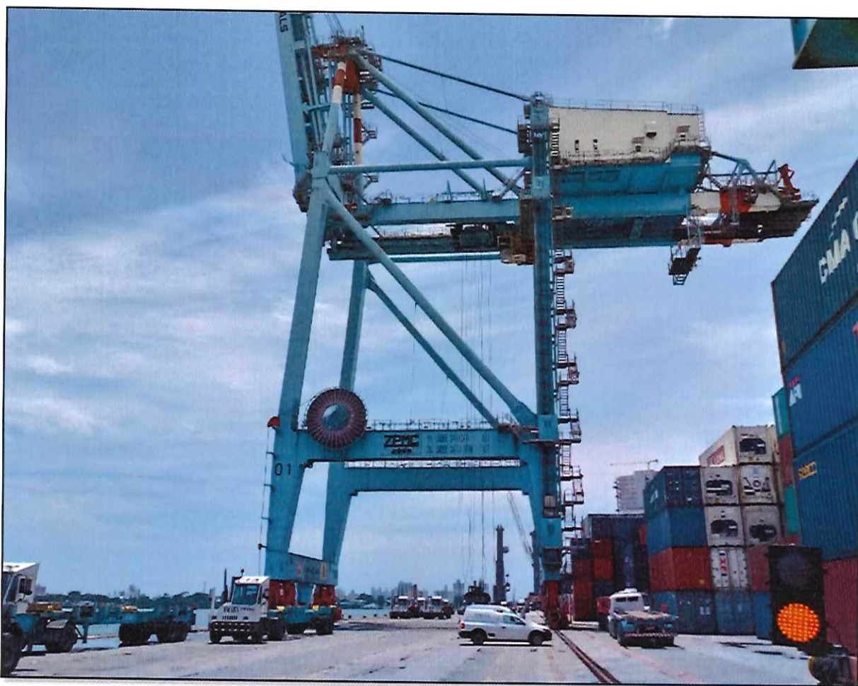
Figura 1. Guindaste de cais (portainer), STS-01.
