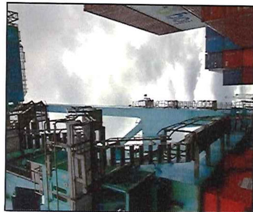
Local: Gantry Item # 09: avaria na escada de acesso.
